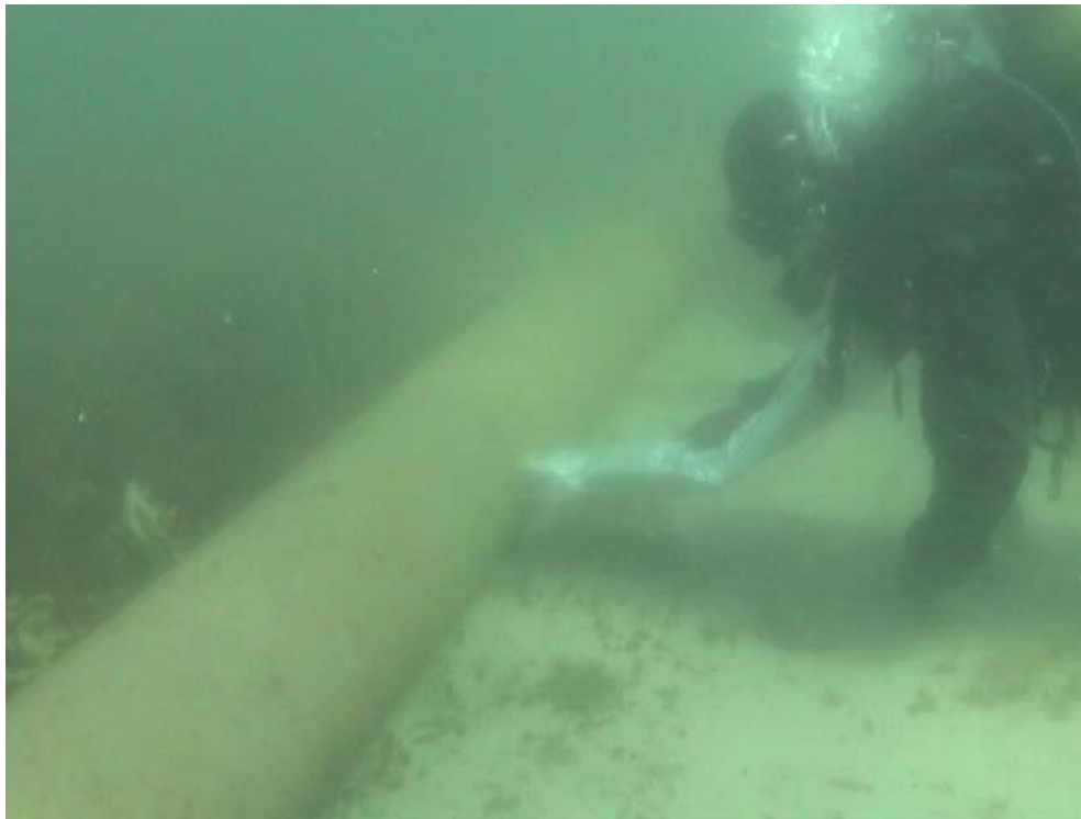
Замеры электромагнитного поля в подводных условиях на кабеле.
