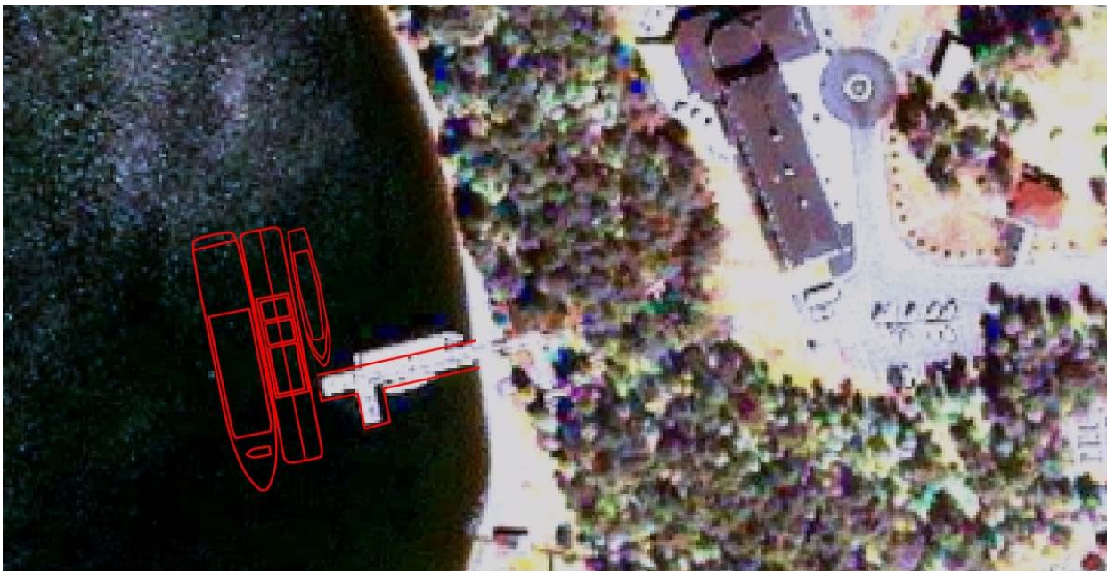
Космоснимок места будущей установки плавучего причала.
