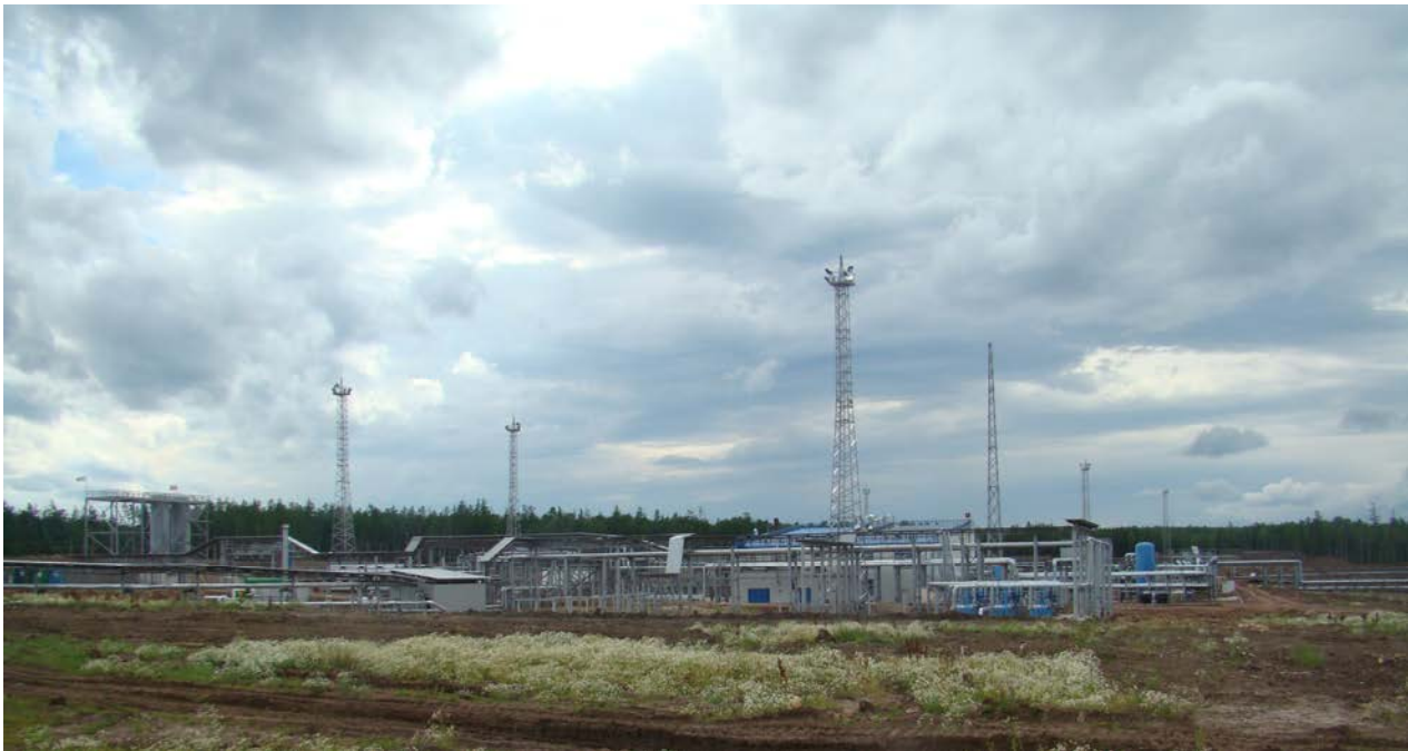
Ярактинский ЛУ, площадка скважины № 15 и участок подготовки газа (УПГ),
