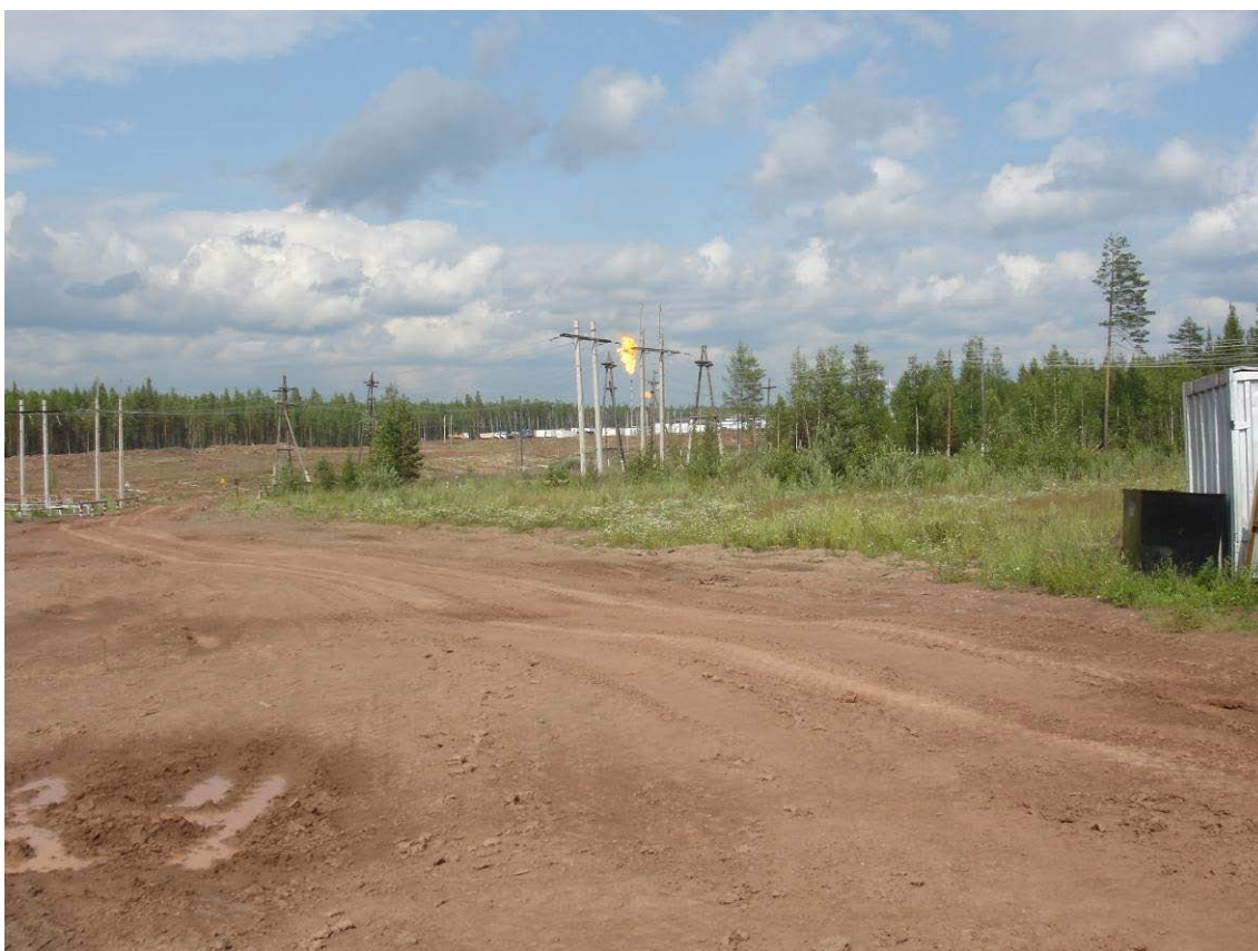
Ярактинский ЛУ, площадка скважины № 15 и участок подготовки газа (УПГ),
