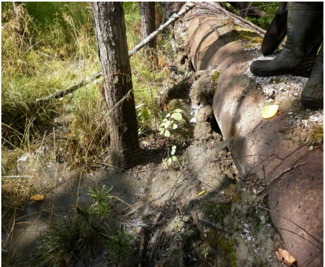
Проливы в пульпопроводе.
