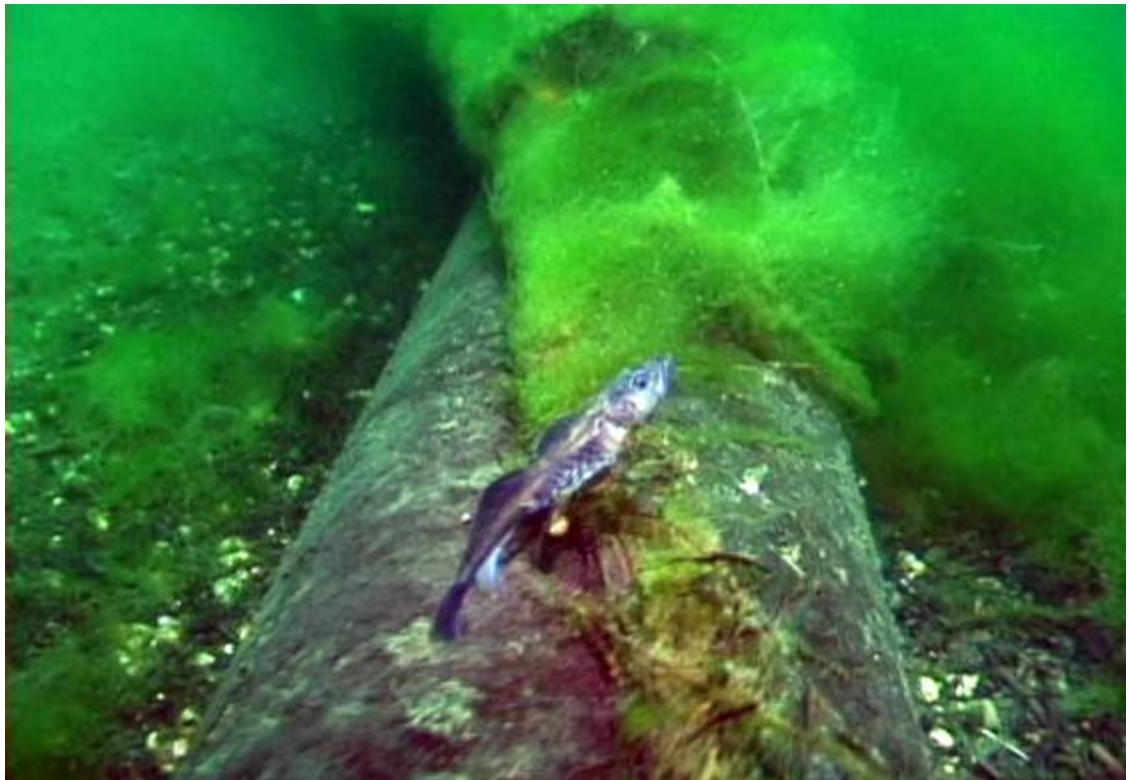
Северобайкальская широколобка на трубе кабеля
